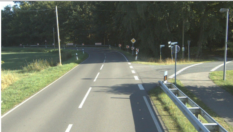
NWSIB Befahrensbild KP L 142_Gemeindestr. Am Walde nördl. Anbindung
